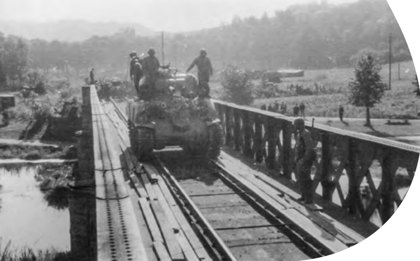
Eisenbahnbrücke in Diekirch, 11.09.1944 Pont de chemin de fer à Diekirch, 11/09/1944 © MNHM / Coll. Roland Gaul
